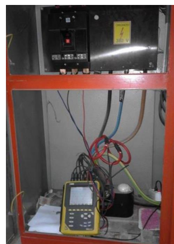
Слика 1 Фотографија мерног места са прикљученим мерним инструментом
